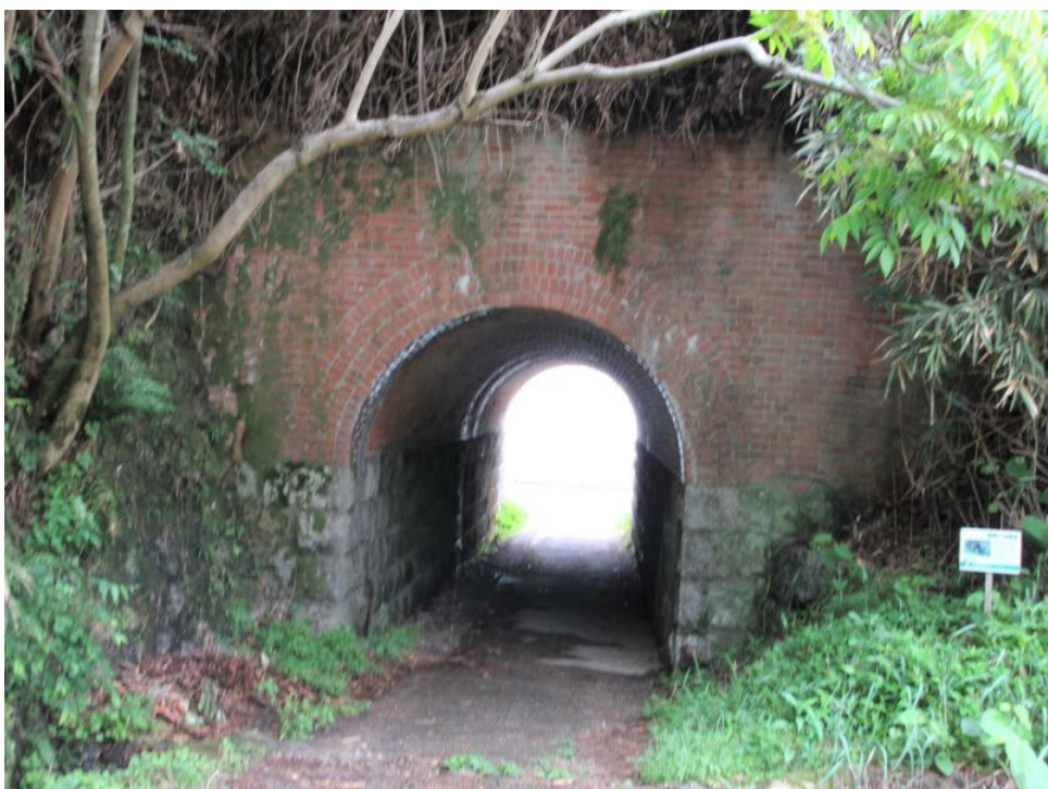
梶ヶ谷隧道正面
