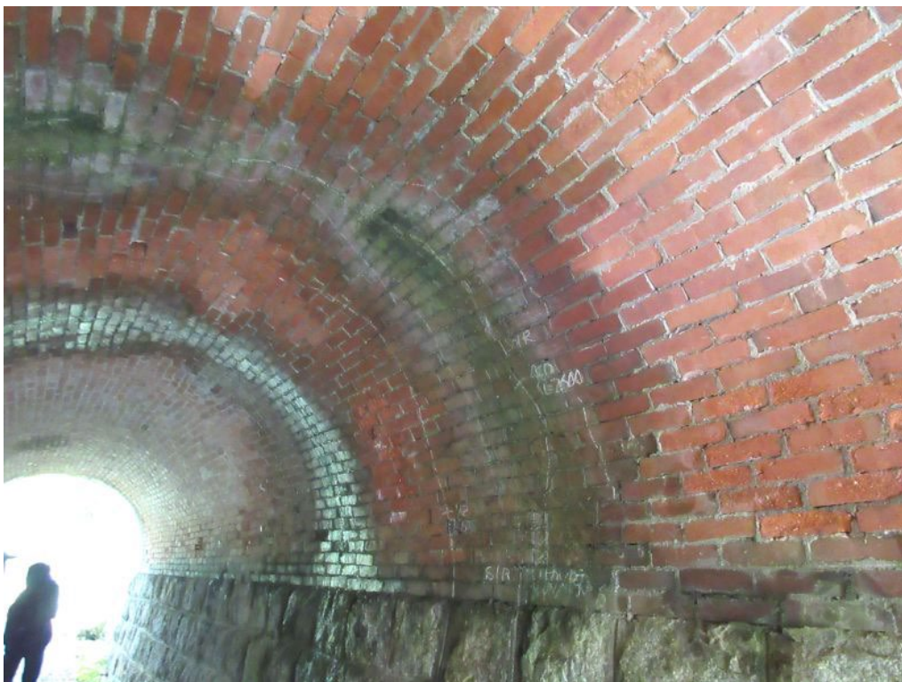
梶ヶ谷隧道トンネル
