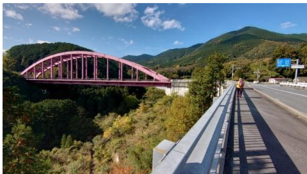
あの橋まで随分あるけど、目指す博物館は橋を渡ると見えてくる 橋の下を覗くと深い谷！ 足がすくみそう
