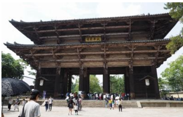
五間三戸二重門入母屋造。大仏様。正治元年(1199)に重源により再建され、建仁3年(1203)仁王像開眼供養が行なわれた。発掘調査により現在の基壇(鎌倉時代)の下から凝灰岩製の奈良時代の基壇が検出され、当初から現在の規模の門であったと推定される。
