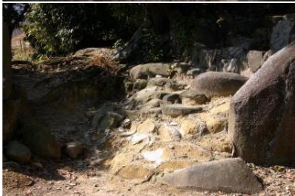
写真下 斜めの石が張り石の残り
